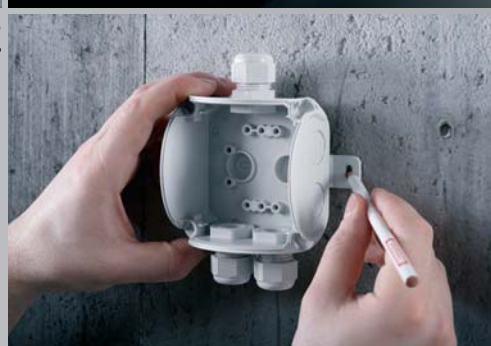
Yttre fästöron levereras alltid med i dosan.
