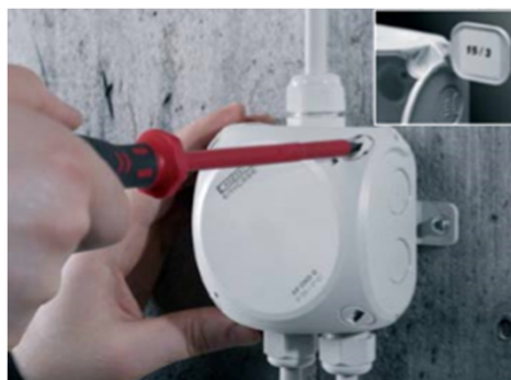
Snabbstängning med kvartsvarvsskruvar.
